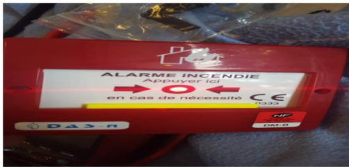
Le déclencheur manuel s'allume rouge lorsque qu'il est enclenché et fait remonter une information a la centrale.
