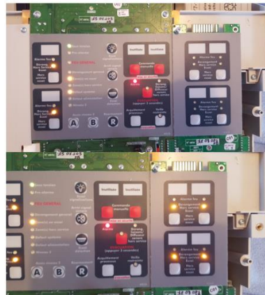
Pour programmer une ZD nous allons rentrer au niveau 3 à l'aide du code 'Ab A.B.A.B.Ab' Pour ensuite créer cette ZD nous allons appuyer sur la touche 'Hors service / Essais' de la ZD correspondante comme ci dessous.
